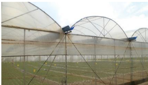
Hình 24.3. Nhà kính liên hoàn
